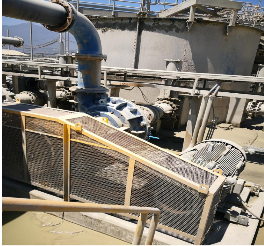
Ilustración 4: Estanque y Bombas Warman. Fuente: Visita MVC.
