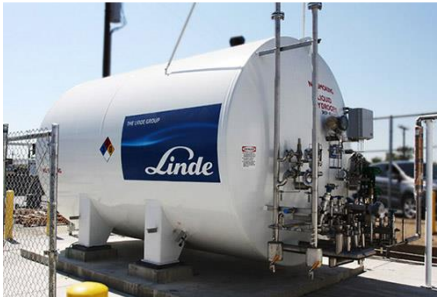
Figura 39: Tanque de hidrógeno líquido
