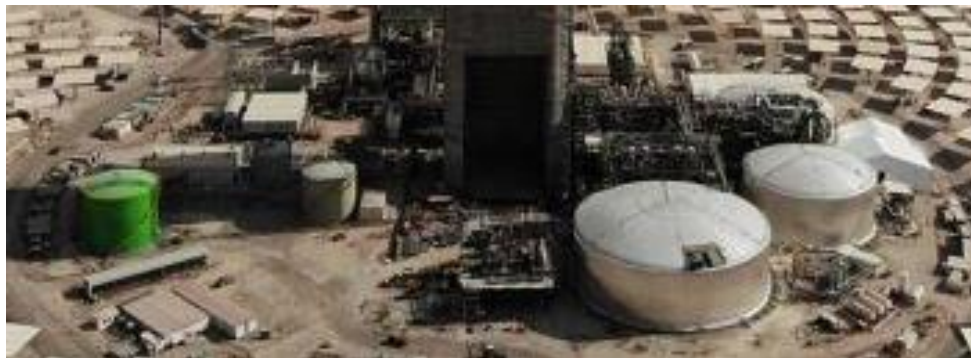
Figura 2: Sistema de almacenamiento con sales fundidas de 110 MWe y 17 horas en el proyecto de torre CSP Cerro Dominador en Chile (13)
