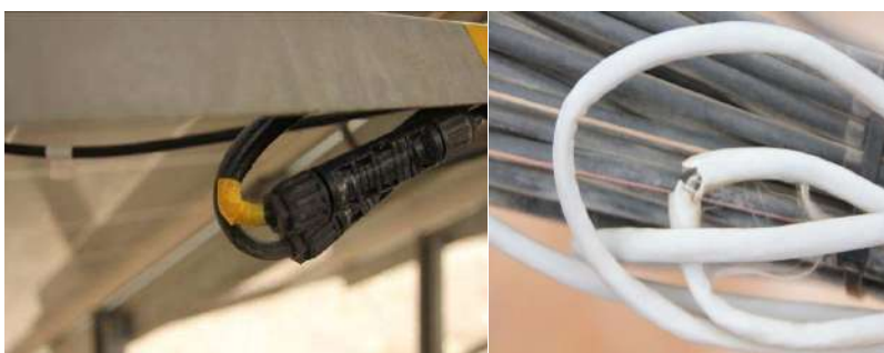
ILUSTRACIÓN 59 IZDA: INCOMPATIBILIDAD DE CONECTORES MC 4 (FUENTE: PI BERLIN AG); DCHA: FALTA DE IDONEIDAD PARA EXTERIOR DE LOS CABLES (FUENTE: PI BERLIN AG)
