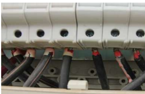
ILUSTRACIÓN 61 : SUJECIÓN INADECUADA DE LOS TERMINALES DE LOS CABLES DE STRING Y RECALENTAMIENTO DE LOS MISMOS (FUENTE: PI BERLIN AG)
