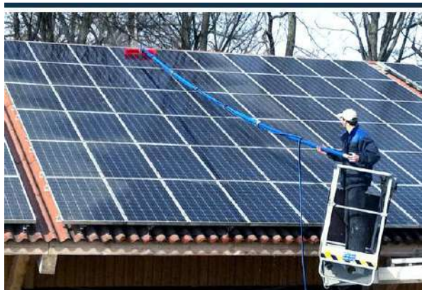
ILUSTRACIÓN 18 PLATAFORMA ELEVADORA Y EQUIPO DE PROTECCIÓN PERSONAL (FUENTE: FLORIAN LÖW, PV-REINIGUNGSSERVICE.DE)
