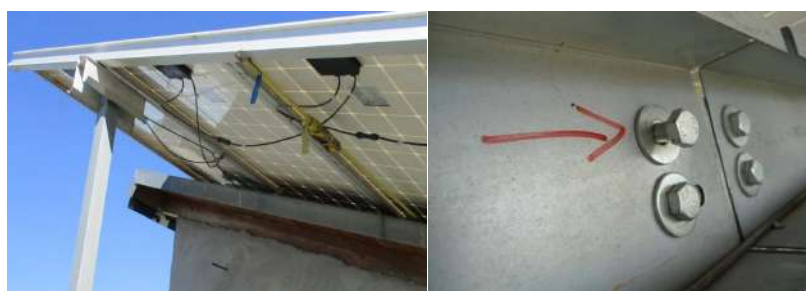
ILUSTRACIÓN 65 IZDA: SUJECIÓN DE LOS MÓDULOS A LA ESTRUCTURA DEL TEJADO CON CINTAS DE AMARRE (FUENTE: PI BERLÍN AG); DCHA: AFLOJAMIENTO DE LOS TORNILLOS DE SUJECIÓN DE LOS PERFILES TRANSVERSALES (FUENTE: PI BERLÍN AG)
