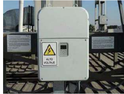
ILUSTRACIÓN 4 INVERSOR DE 33 kW (FUENTE: MINISTERIO DE ENERGÍA)
