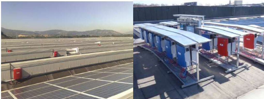
ILUSTRACIÓN 38 IZDA: INVERSORES DESPROTEGIDOS DEL EFECTO DE RADIACIÓN SOLAR DIRECTA (FUENTE: DGS BERLÍN E. V.); DRCHA: INVERSORES PROTEGIDOS DE LA RADIACIÓN SOLAR DIRECTA (FUENTE: PI BERLÍN AG)
