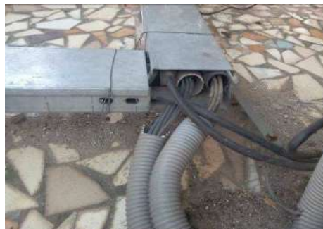
ILUSTRACIÓN 60 IZDA: SELLADO INADECUADO DE ORIFICIOS (FUENTE: PI BERLIN AG); DCHA: CUARTEAMIENTO DE LA ENVOLVENTE DEL CABLE (FUENTE: PI BERLIN AG)
