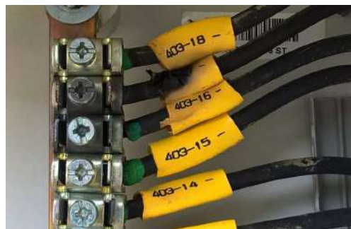
ILUSTRACIÓN 61 : SUJECIÓN INADECUADA DE LOS TERMINALES DE LOS CABLES DE STRING Y RECALENTAMIENTO DE LOS MISMOS (FUENTE: PI BERLIN AG)
