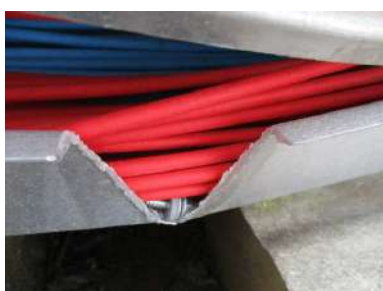
ILUSTRACIÓN 62 DAÑOS EN EL CABLEADO POR ABRASIÓN PRODUCIDA POR ARISTAS VIVAS (FUENTE: PI BERLIN AG)
