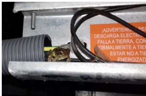
ILUSTRACIÓN 60 IZDA: SELLADO INADECUADO DE ORIFICIOS (FUENTE: PI BERLIN AG); DCHA: CUARTEAMIENTO DE LA ENVOLVENTE DEL CABLE (FUENTE: PI BERLIN AG)
