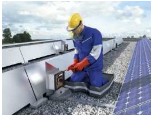
ILUSTRACIÓN 21 EQUIPO PROTECCIÓN PERSONAL PARA TRABAJAR EN SISTEMAS ENERGIZADOS DE BAJA TENSIÓN (FUENTE: H.ZWEI.S GMBH)
