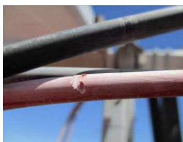
ILUSTRACIÓN 62 DAÑOS EN EL CABLEADO POR ABRASIÓN PRODUCIDA POR ARISTAS VIVAS (FUENTE: PI BERLIN AG)
