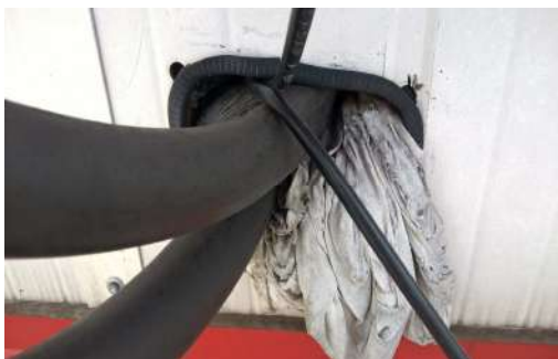
ILUSTRACIÓN 58 FALTA DE SELLADO DE LOS TUBOS DE ACOMETIDA (FUENTE: PI BERLIN AG)
