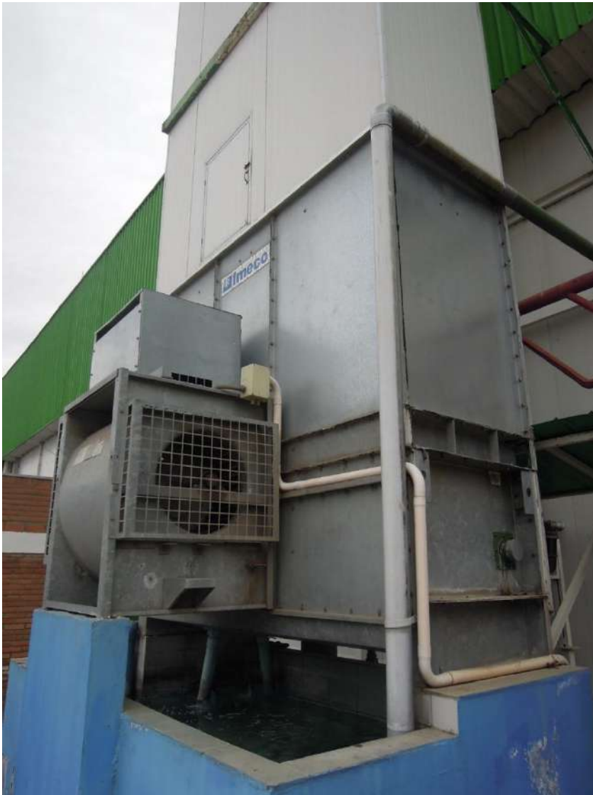
Ilustración 60: Torre disipadora de calor en planta Frunar (Fuente: Visita a planta 08-09-2016).
